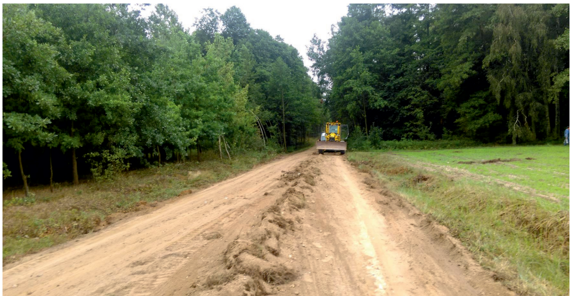
Naprawa drogi w kierunku Zygmuntówka
